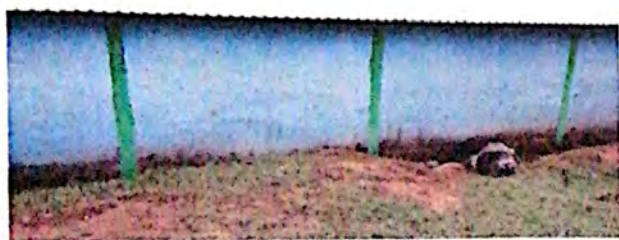
Foto 5: Cubierta de lamina de cocina
