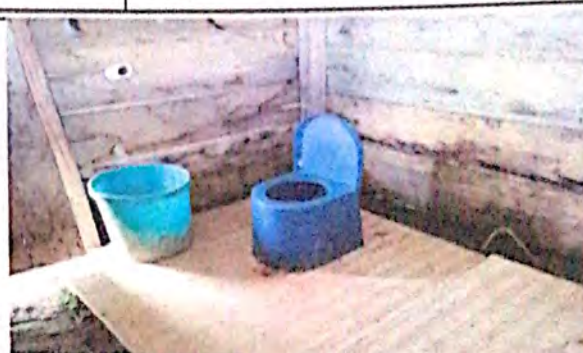
Foto 2: Sustitución de Servicio Sanitario
