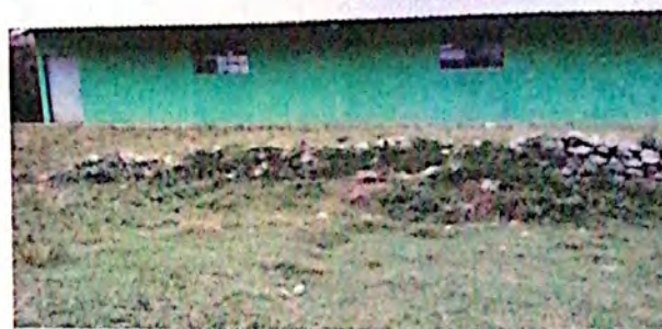
Foto 6: Ampliación de Corredor
