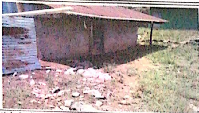
Foto 1: Ampliación de Cocina
