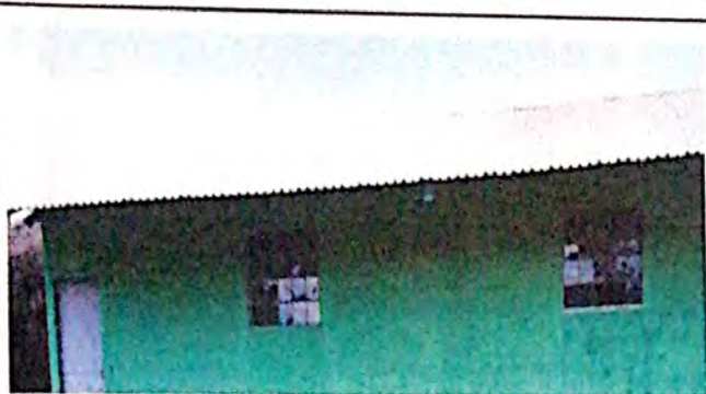
Foto 3: Ampliación de Ventanas
