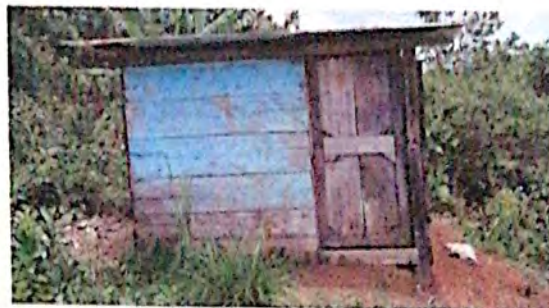
Foto 4: Sustitución de puertas de madera por metal
